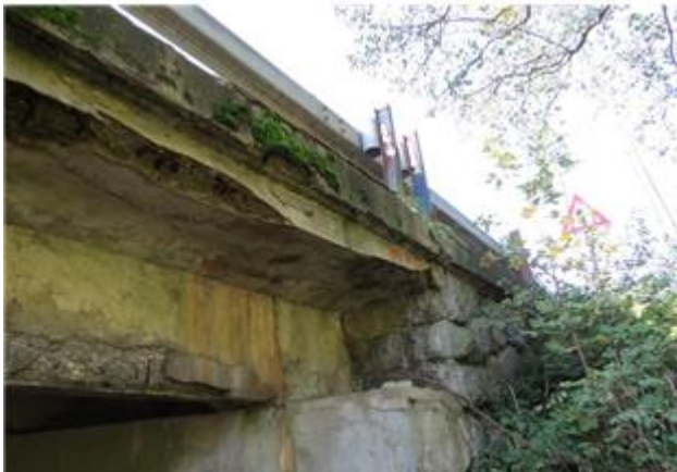
Názov: 527-015_vymyté_škáry_na_opore.JPG
